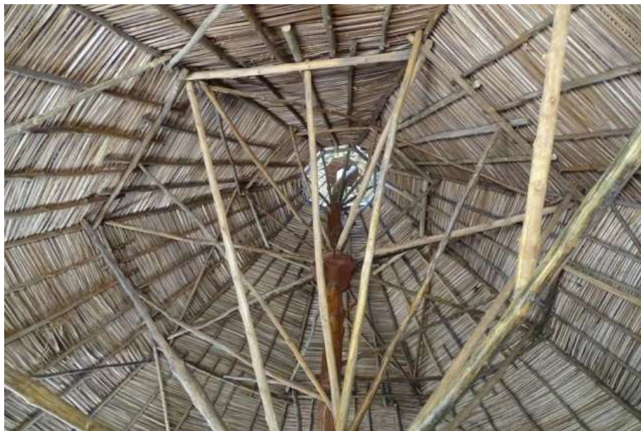
Dakconstructie van de eetzaal van de Ensenada Lodge.
